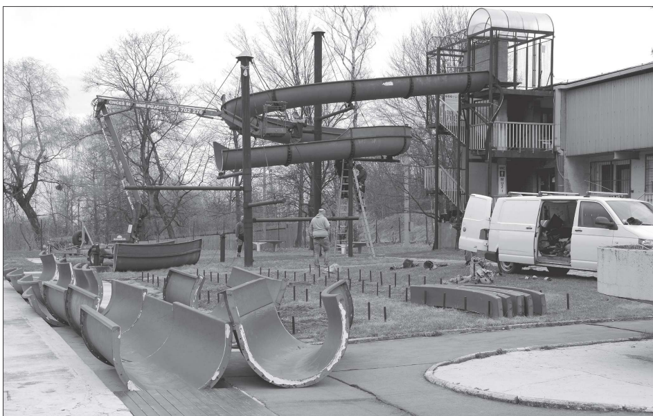
Pracovníci vybrané firmy v minulém týdnu demontovali dosloužilý tobogán na kopřivnickém koupališti. Důvodem jeho avizované likvidace byl technický stav, který neumožňoval bezpečné provozování atrakce.
